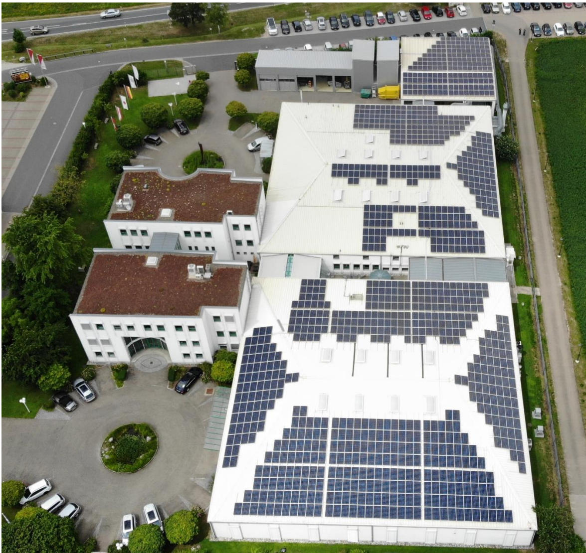
Abbildung 2: PV-Anlage auf den Dachflächen der Fertigungshallen
