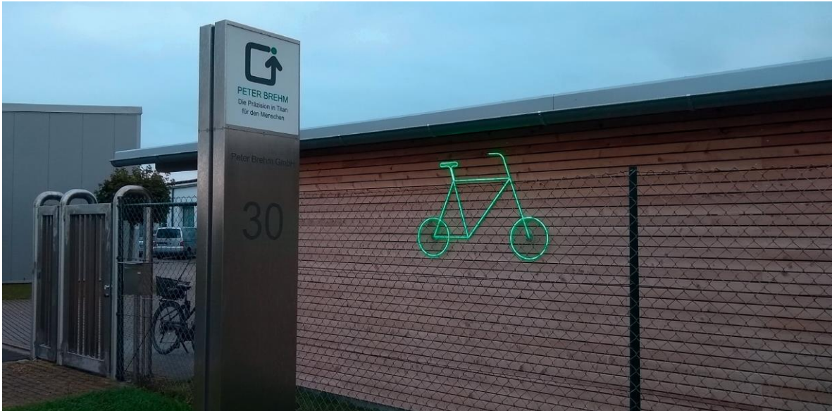
Abbildung 3: neu errichtete abgeschlossene Fahrradgarage mit Lademöglichkeiten für E-Bikes
